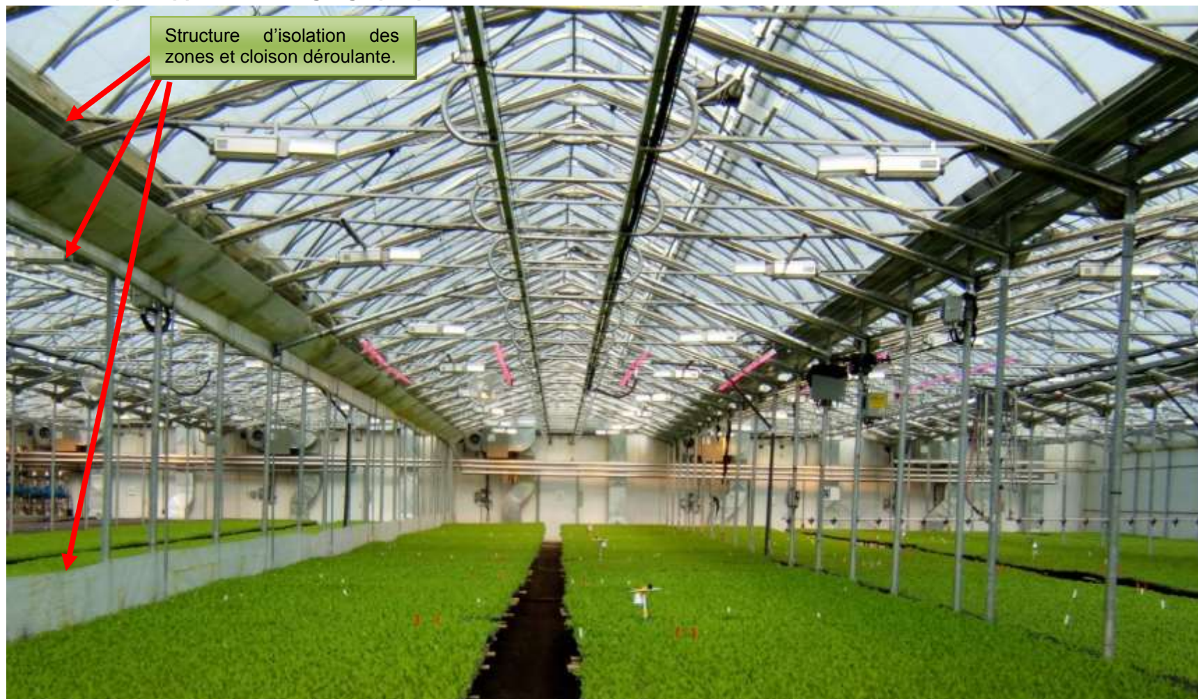
Photo 19 : Les Serres Lefort - Serre 36 - Structure pour la cloison déroulante du côté ouest (par convention ou sud-ouest par rapport au nord géographique)
