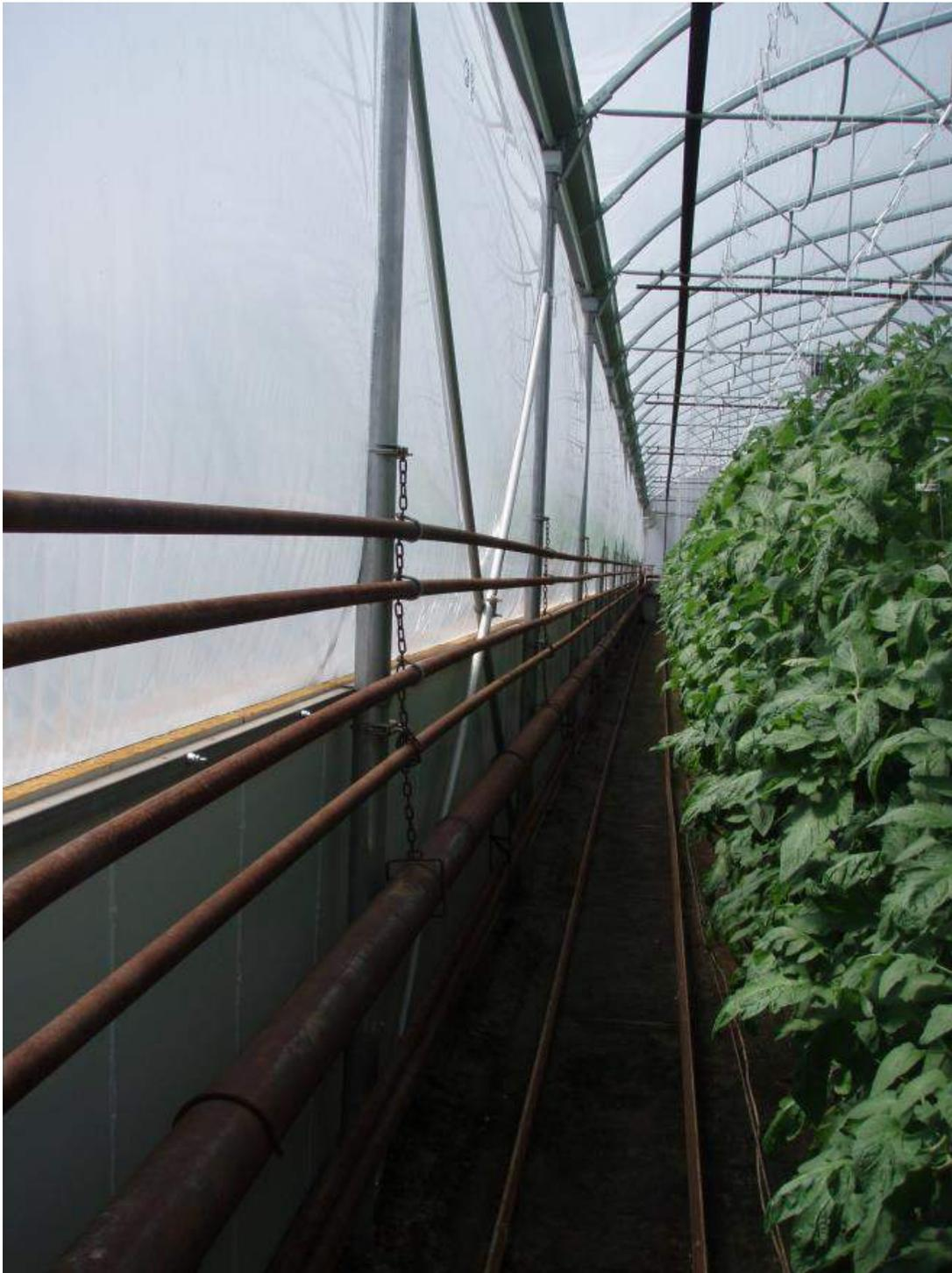
Note : il faut éviter que les tuyaux d'eau chaude soient localisés vis-à-vis une surface non isolée.
