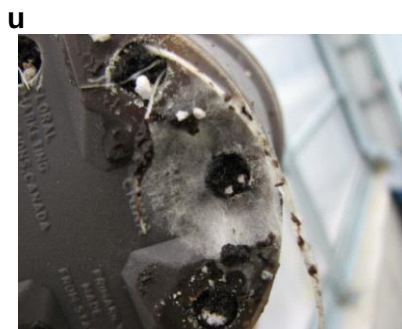
u Moississures en dessous
